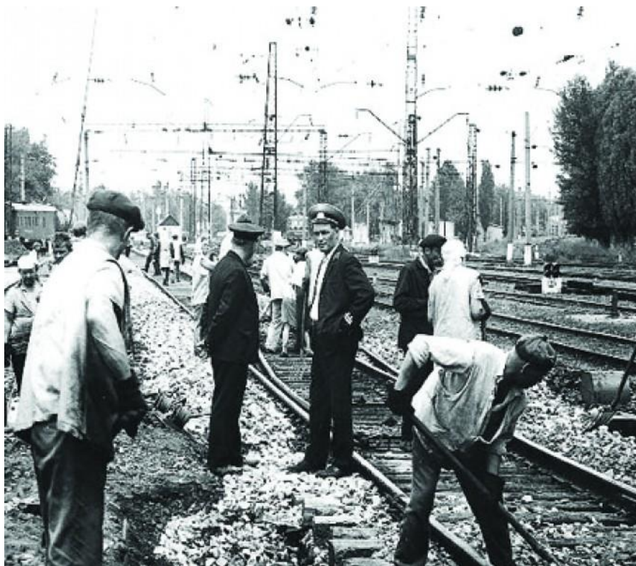
Станция Каменоломни (ремонтные работы)
